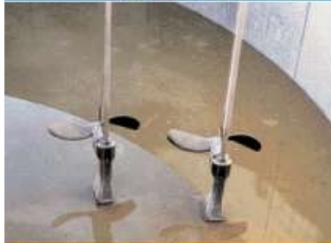
Les agitateurs grandes pales permettent de maintenir les boues en mouvement, même pendant les phases d'arrêt de l'aération
