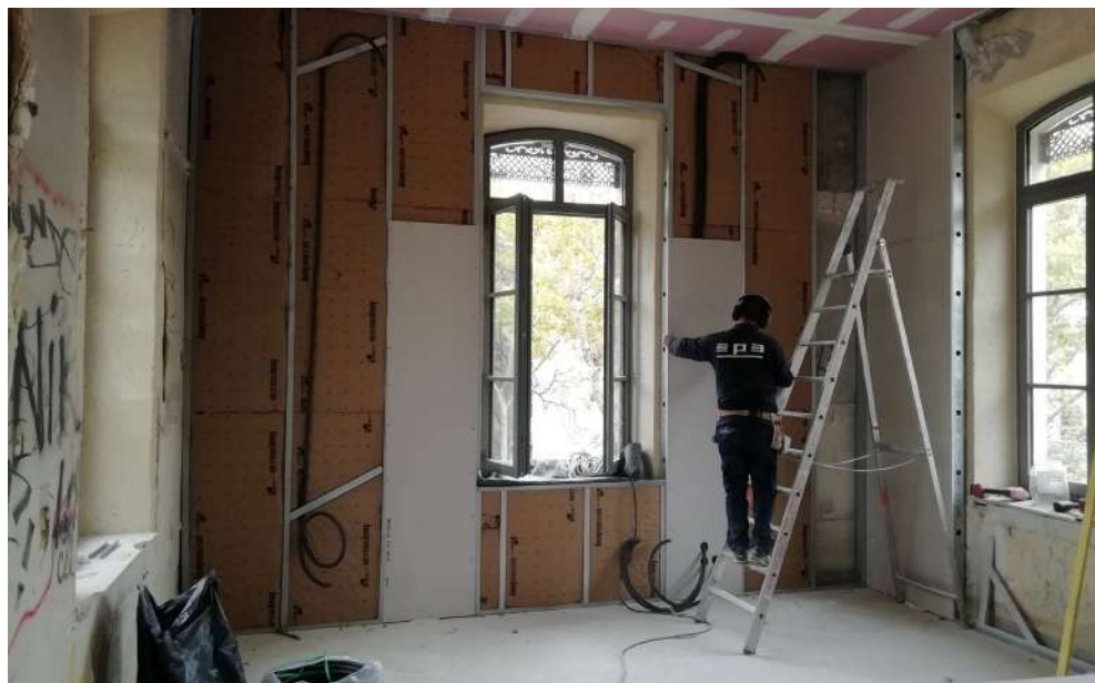
▲ Doublage murs extérieurs
