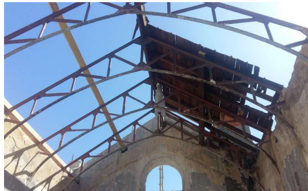
▲ Dépose ancienne charpente bois Conservation charpente métallique
