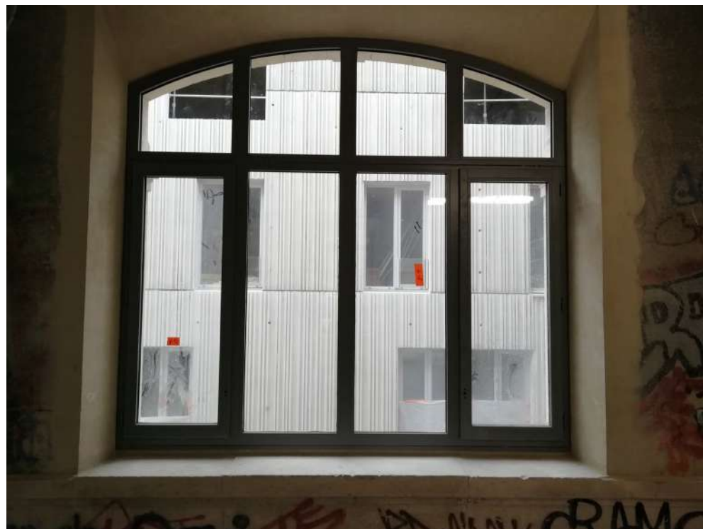
▲ Pose nouvelles menuiseries bois
