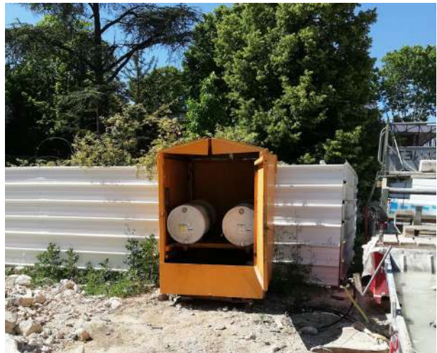
Stockage abrité bidons huiles décoffrage
