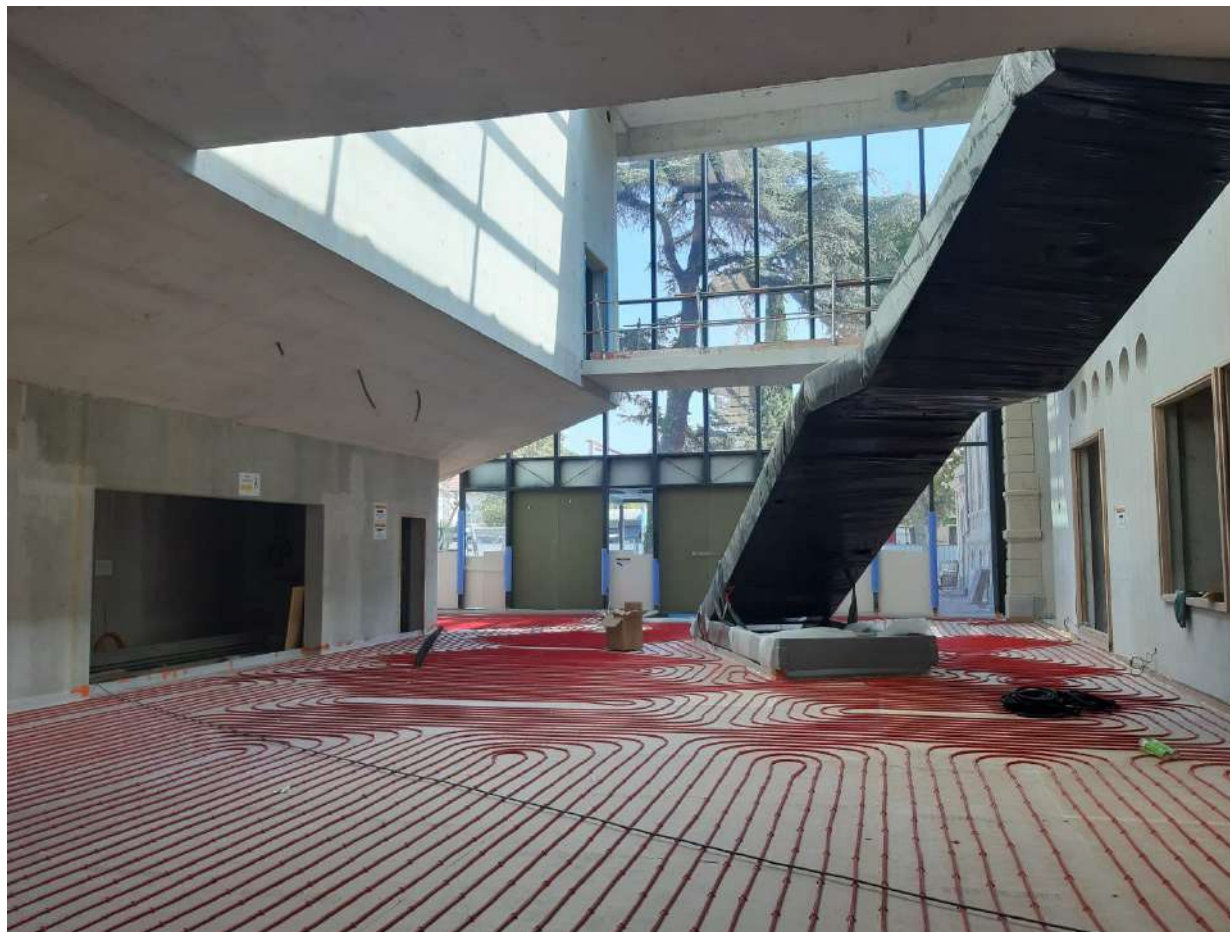
▲ Plancher chauffant du hall
