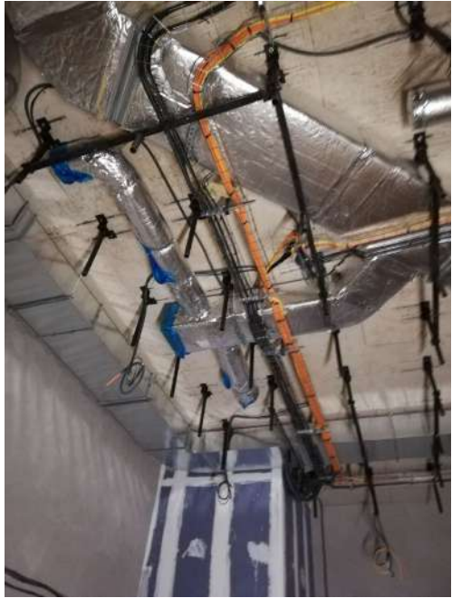
Protection des gaines pour éviter l'empoussiérage
