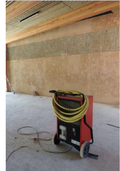
Séchage des murs chanvre
