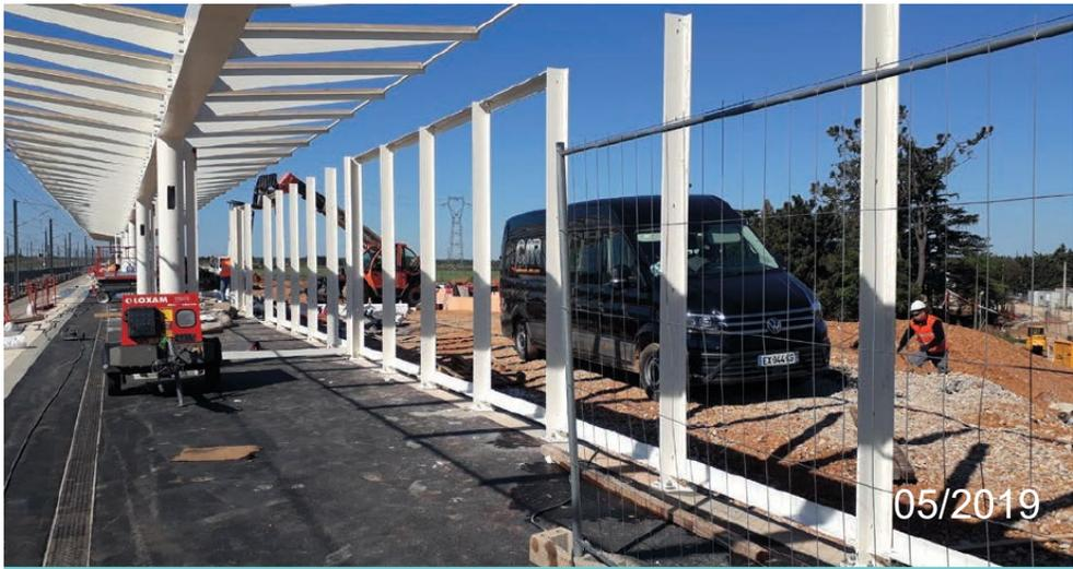
**Avancement des quais : enrobés, charpente des abris en zinc et voliges en peuplier, paravents et garde-corps**
