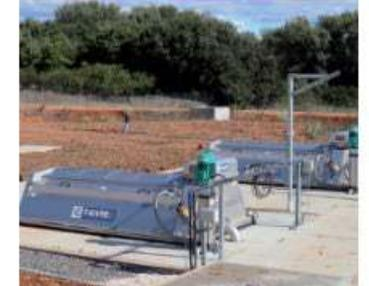
2 filtres tertiaires sont installés entre les clarificateurs et le comptage
