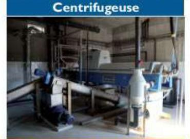
Séparation des phases solides (boues) et liquides (eaux) par centrifugation
