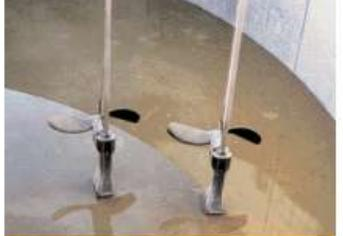
Les agitateurs grandes pales permettent de maintenir les boues en mouvement, même pendant les phases d'arrêt de l'aération
