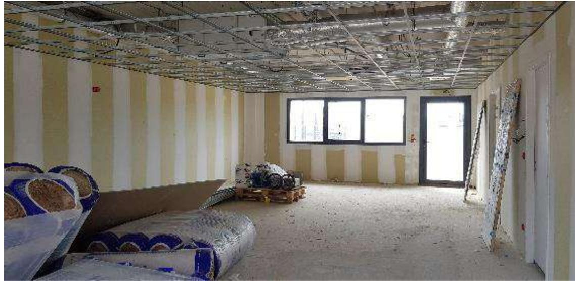
Mise en œuvre d'un isolant laine de verre à base de liant Ecosse dans les faux plafonds
