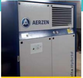
3 compresseurs capotés de 90 kW alimentent en air les diffuseurs
