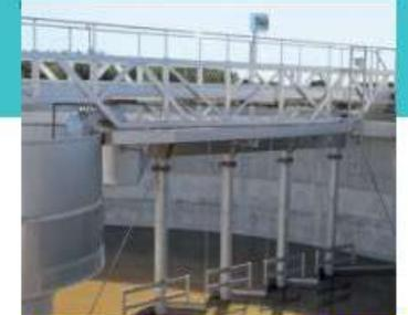
Le pont aspire les boues décantées au fond de l'ouvrage et racle les flottants en surface
