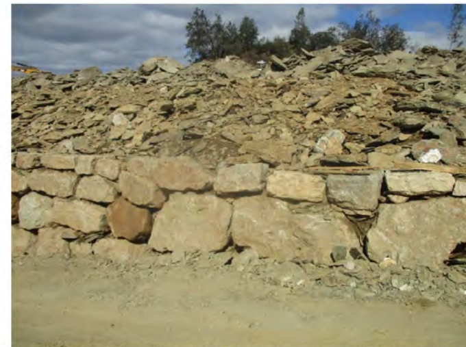
Remblais avec matériaux issus du site sur le linéaire Est de la plateforme et fin de l'enrochement en haut de la rampe d'accès
