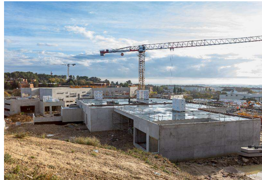
Travaux toiture terrasse
