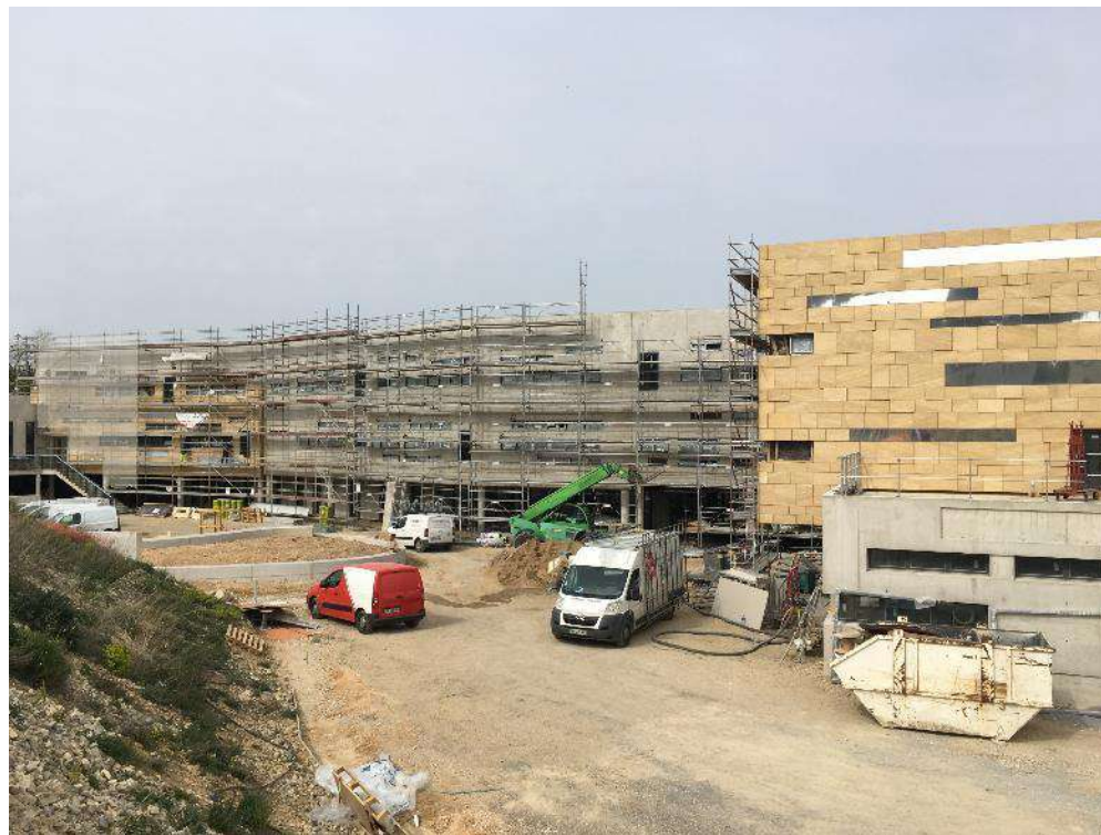
Façade en pierre , mise en œuvre BSO
