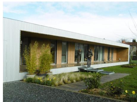
Maison contemporaine et bioclimatique sur pilotis, adaptée à un terrain très contraignant : faible surface, faible largeur, situé en contrebas d'une colline d'où s'écoulent les eaux de pluie.
