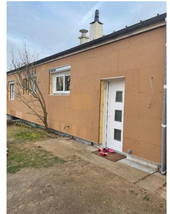
ITE en laine de bois sur ossature et finition fibre de bois haute densité « prêt à enduire » (Vayres-sur-Essonne, Essonne)
