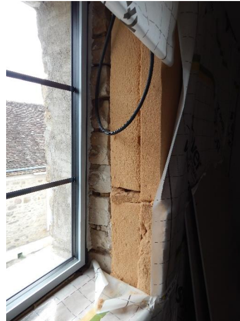
ITE en laine de bois sur mur ancien en pierre avec pare-vapeur (Soisy-sur-École, Essonne)
