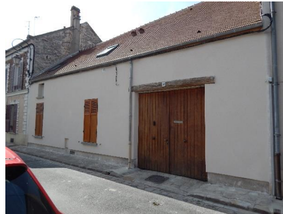
ITE en béton de chanvre 12 cm et enduit de finition (Milly-la-Forêt, Essonne)
