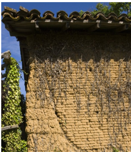
Fig. 4 : Élévation d'une grange partiellement bâtie en briques de terre crue (Tarn-et-Garonne). (Photo : P. Poitou)
