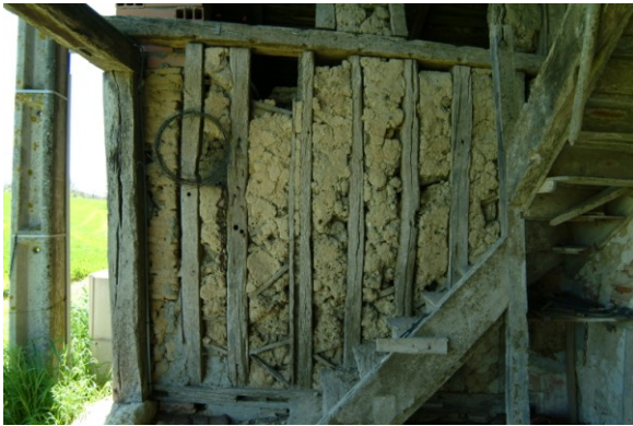
Fig. 3 : Détail d'une cloison en pans de bois et torchis. En vidalot (Tarn-et-Garonne). (Photo : P. Poitou)
