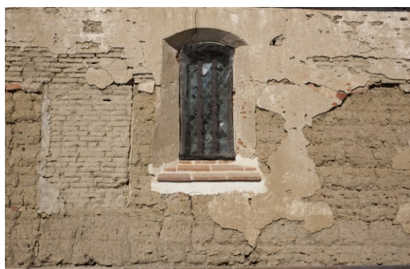
Fig. 1 : Détail d'un mur de la chapelle Saint-Clair à Pompignan (Tarn-et-Garonne). La partie inférieure est en terre massive ( tàpia ). (Photo P. Poitou)
