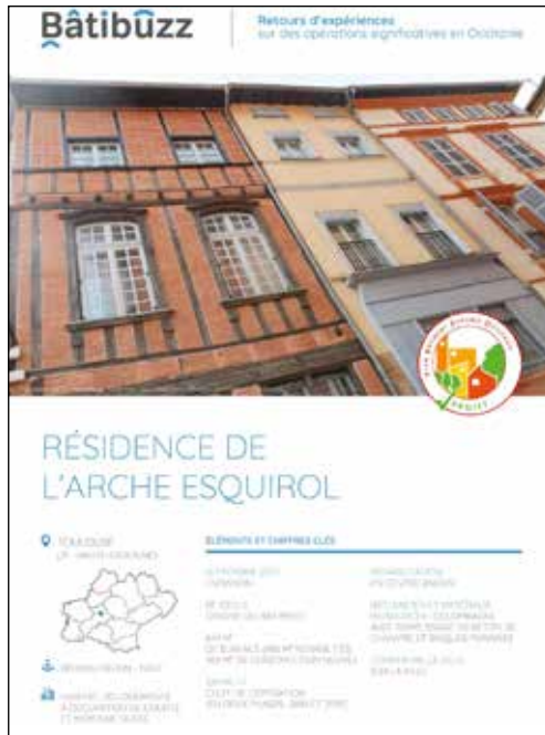
Réhabilitation de l'Arche Esquirol, en centre ancien de Toulouse
