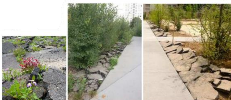
le traitement des tranchées et des massifs drainants et infiltrant accompagnant les voies douces et les voies de circulation
