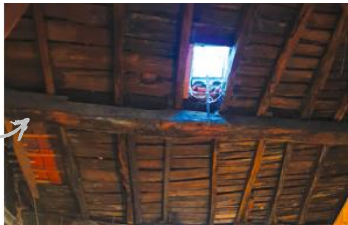
Crédits : AQC – L'isolation des rampants en rénovation
