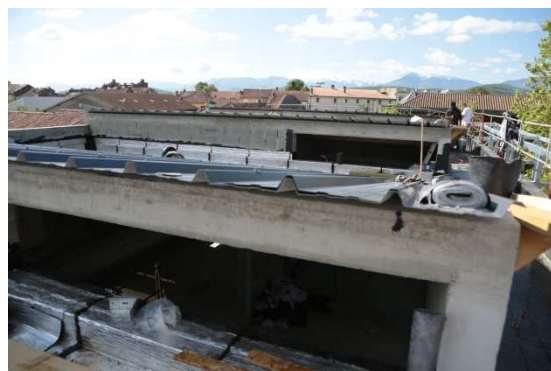
Préparation du toit pour la pose des panneaux photovoltaïques.
