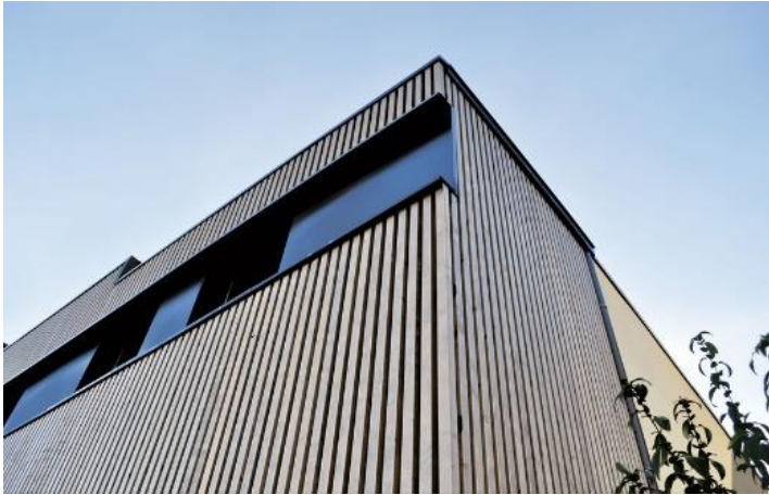
Bardage bois douglas raboté ajouré et finition vieillie - Façades latérales
