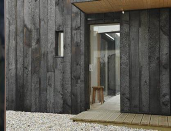
Bardage bois brûlé selon la technique Shou-sugi-ban ou Yakisugi, d'origine japonaise, qui permet de protéger naturellement les bois de bardage par carbonisation. Durabilité 70-80 ans sans aucun traitement. Rez-de-chaussée côté parking + habillage des édicules (locaux déchets et vélos)
