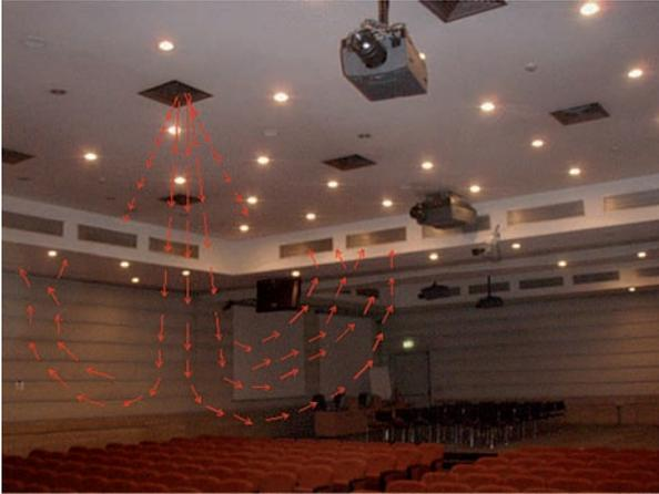
Ventilation schématisée d'une grande salle de réunion avec des apports importants et un gradient de température significatif. L'air pulsé à grande vitesse parvient à vaincre le gradient de température et à descendre avant d'être extrait par les grilles de diffusion.
