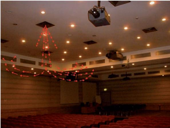
Pour une vitesse d'air réduite de moitié en sortie de bouche de diffusion, l'air chaud ne descend pas jusqu'aux fauteuils et est directement repris par les grilles de diffusion. L'inconfort thermique ne sera pas décelé par une sonde de température placée en reprise.
