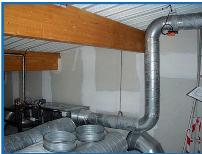
Photographie des gaines et du caisson de ventilation de la salle de gymnastique.
