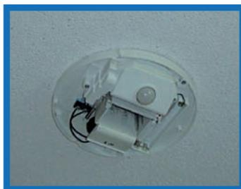
Capteur optique de présence installé sur faux plafond. Dans ce cas, l'opération de maintenance consistait à changer les batteries, après la constatation de l'arrêt de fonctionnement.
