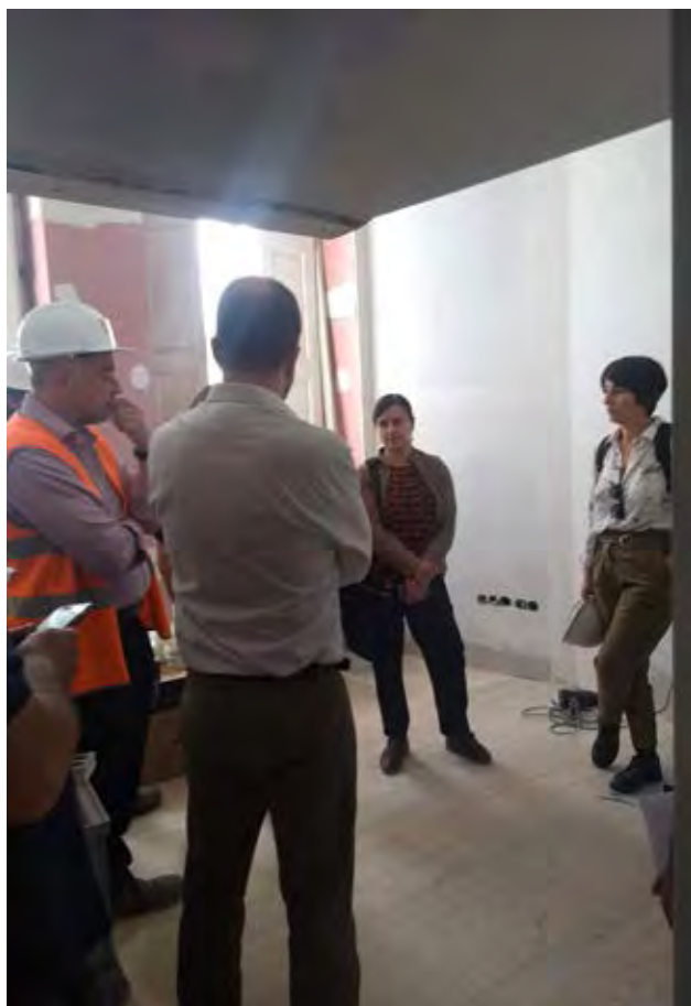
Atelier participatif, visite du chantier.
