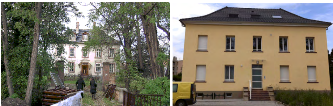
Figure 2 : Illustration des enjeux culturels associés à perte de valeur architecturale après réhabilitation énergétique (photographies avant et après travaux – source : DRAC Grand Est)
