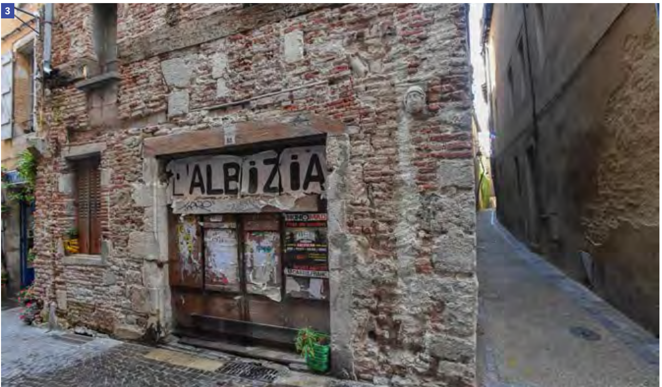
1. Façade avant travaux.
