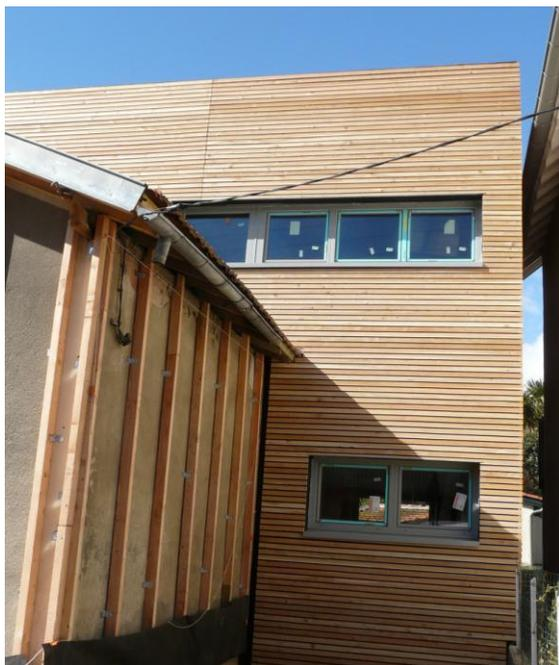
L'ossature primaire en bois fixé sur les murs de l'existant, recevra de la laine de chanvre en remplissage et des panneaux de fibre de bois enduits en finition.
