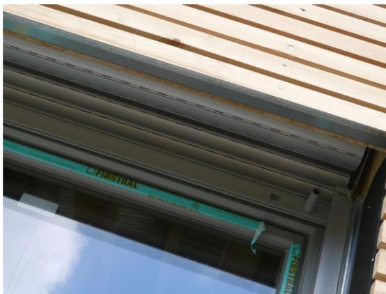
Les huisseries en PVC, ont un double vitrage au Uw de 1,3, et des volets roulants dont le coffre est intégré dans l'ossature bois et non visible car caché par le bardage.
