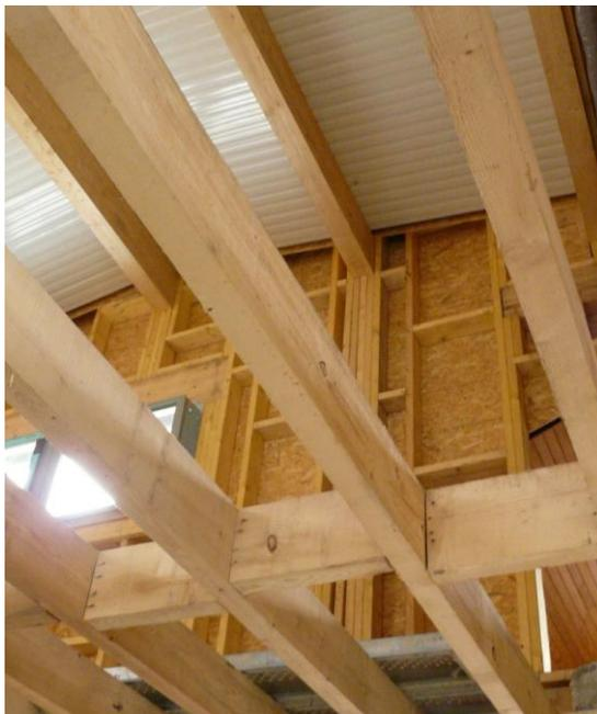
La structure bois du plancher intermédiaire de l'extension en premier plan, en arrière plan l'ossature bois des murs avec les panneaux OSB, et la couverture en bacs acier.
