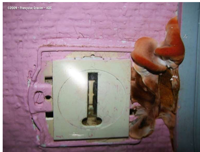
Figure 13 - Développement d'un champignon dans une prise téléphonique, dû à un défaut de ventilation. (Source : AQC)
