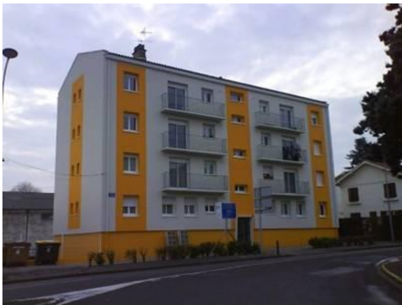
Figure 10: Vue du bâtiment après réhabilitation
