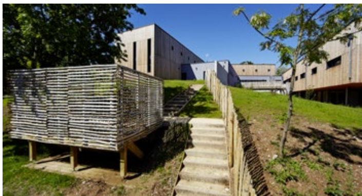
Le visage privé du bâtiment tourné vers la vallée du Lot - Photo © Nelly Blaya CD46
