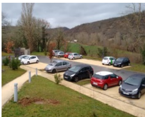
Zone de stationnement et cheminements piétons en stabilisé - Photo © CeRCAD
