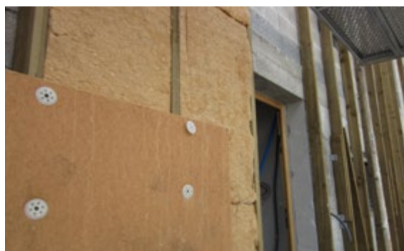
Isolation par l'extérieur en fibre de bois - Photo © ADEME
