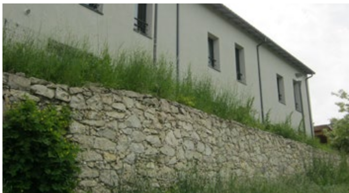
Mur de soutènement du bâtiment 1 reconstruit en pierre préservant le caractère rural du nord-ouest de la parcelle - Photos © CAUE 32
