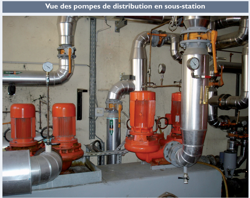
Figure 24 : Vue des pompes de distribution en sous-station
