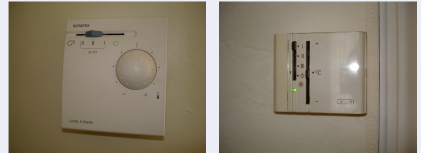
Figure 31 : Vues de deux exemples de boîtier de régulation
