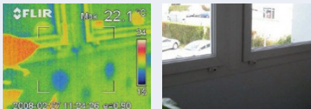
Figure 7 : Analyse thermographique des parois
