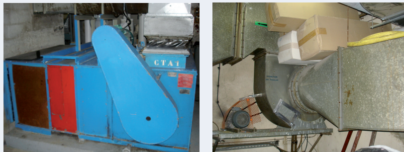
Figure 26 : Vue de la CTA n° 1 (soufflage bar Américain) et de l'extracteur associé
