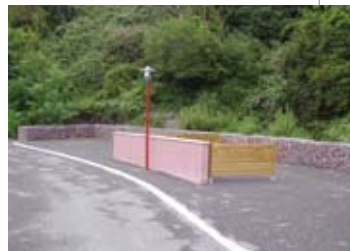
Le quartier du Belvédère à Cransac (12) : aménagement sobre et réseaux de chaleur, notamment pour alimenter les thermes.
