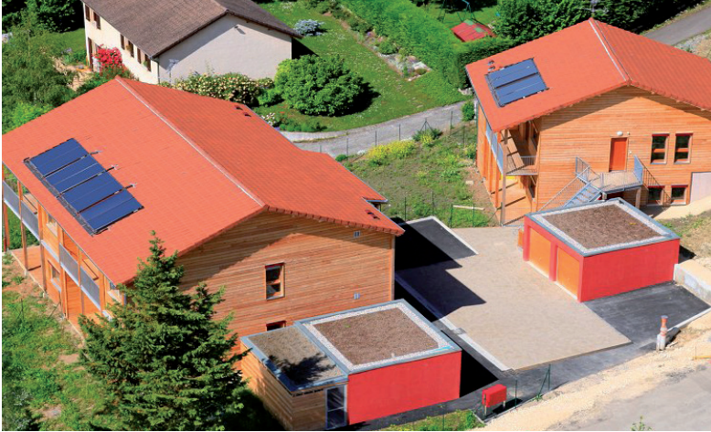
> Le projet de la Petite Chartreuse situé sur la commune de La Terrasse (38) (Photo : Vincent RIGASSI Architecte et Pluralis®)
