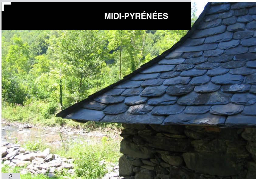
2. Toiture en ardoises posées à pureau dégressif, Ariège.
