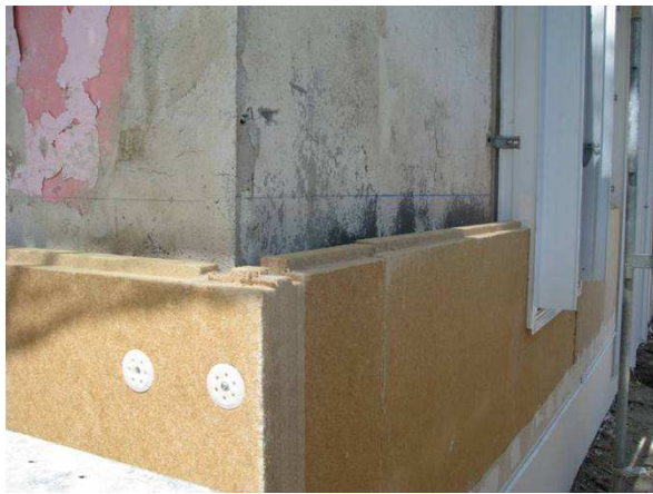
Aux angles, les plaques d'isolant sont appareillées. Les mortaises sont retaillées lorsque nécessaire.
