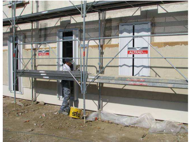
L'enduit de 8 mm à base de chaux est réalisé en 3 passes Il est armé d'une trame de fibre de verre.
