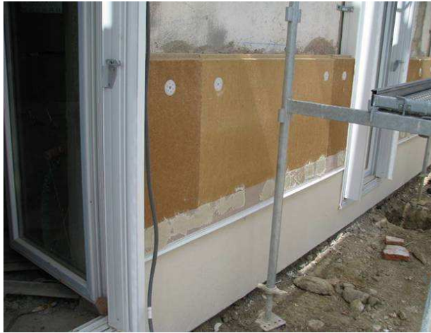
Gestion du soubassement, des plaques de liège isolant le soubassement. Une bavette permet de gérer la transition entre le liège et le feutre de bois.
