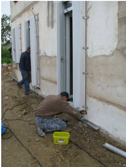
Fixation des butées de support de l'isolation.
