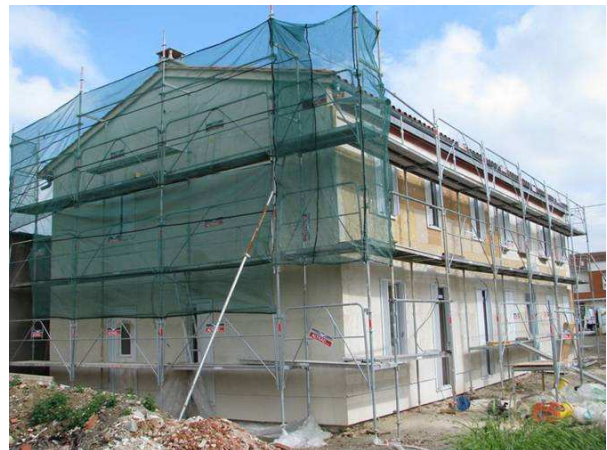
L'enduit de 8 mm à base de chaux est réalisé en 3 passes Il est armé d'une trame de fibre de verre.
