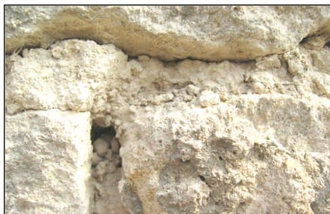
Le mortier de chaux qui liait les pierres entre elles est très fragilisé à l'extérieur comme à l'intérieur. Au toucher il se transforme en poudre, la chaux n'ayant plus de propriété mécanique.
