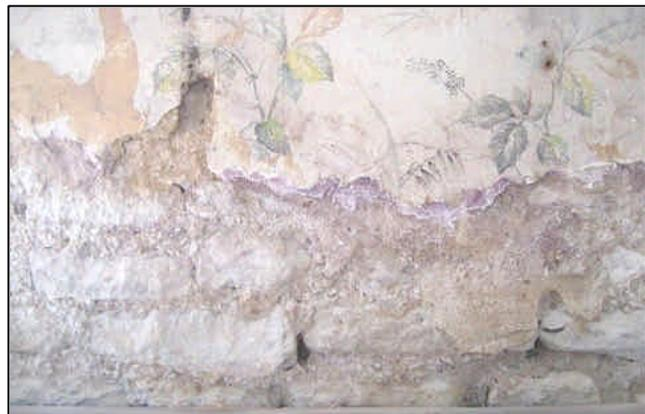
Les enduits à la chaux et la finition au plâtre à l'intérieur sont irrémédiablement perdus sur 60-70% de la surface.
