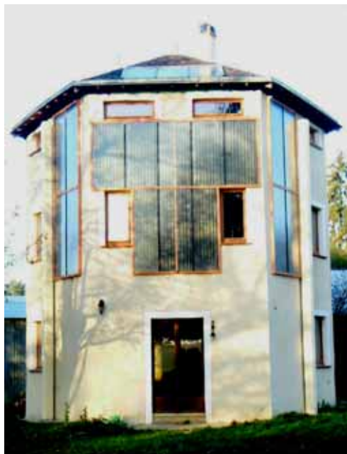
Etat final de la construction (capteurs solaires en façade)
