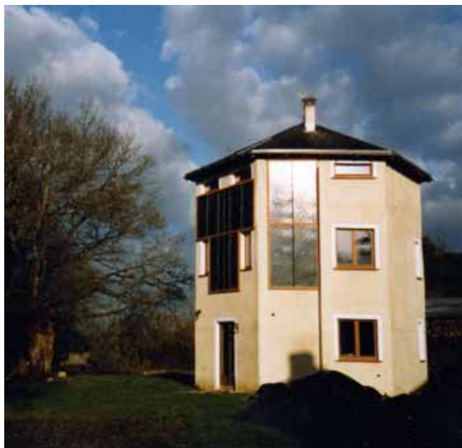
Etat final de la construction (capteurs solaires en façade)
