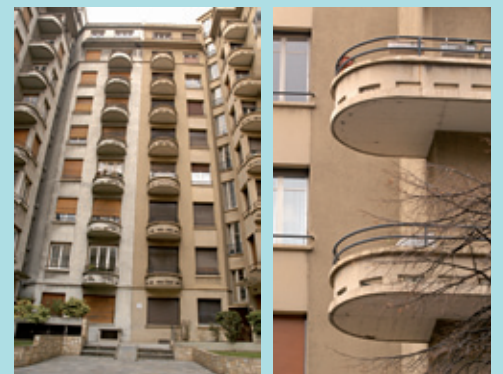
Immeuble 10 cours Gambetta
