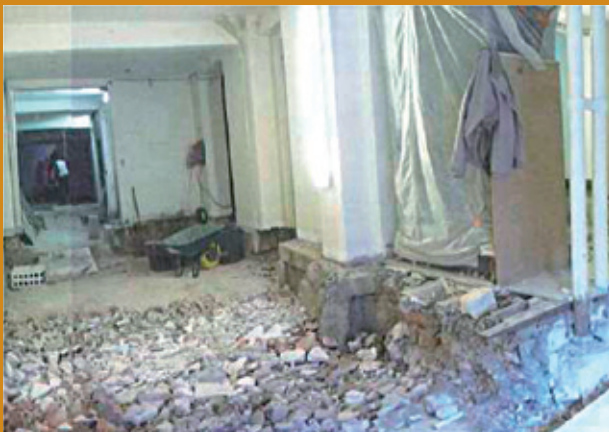
Reconstruction de la dalle.
