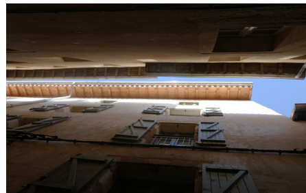
Façade ouest du bâtiment rénové Photos : Envirobat Occitanie
