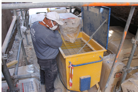
Préparation du béton de chanvre avant projection - Photo : Matthieu BELCOUR
