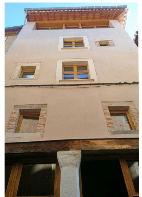
Façade nord du bâtiment rénové Photo : Matthieu BELCOUR
