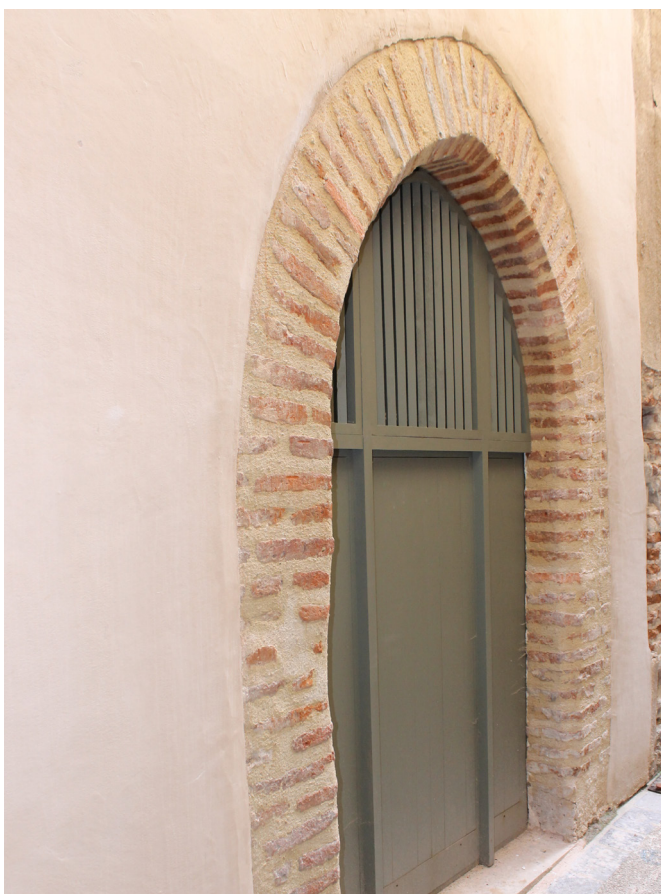
Porte latérale de la façade ouest rénovée Photo : Matthieu BELCOUR
