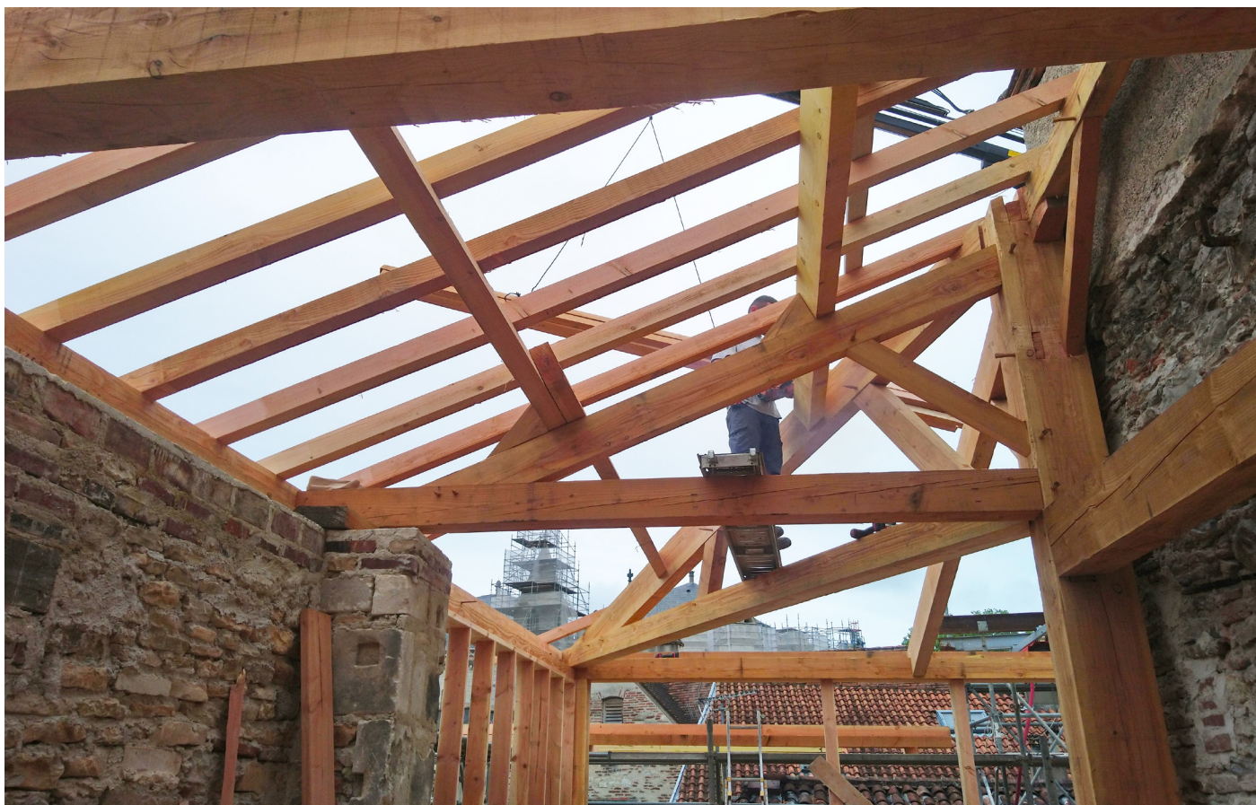
Charpente traditionnelle en bois du dernier niveau - Photo : Matthieu BELCOUR
