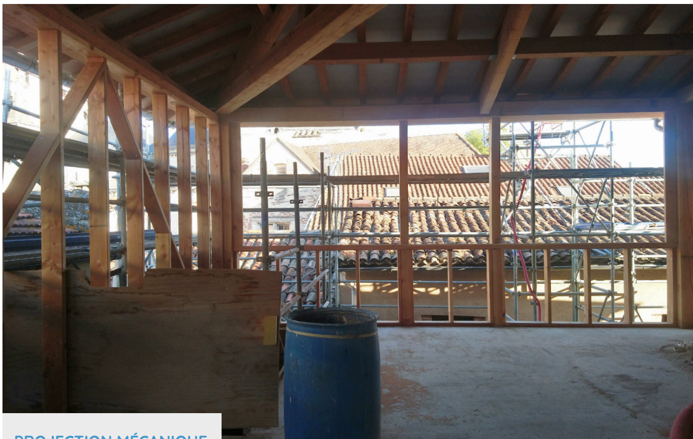
Dernier niveau partiellement refait en ossature bois - Photo : Matthieu BELCOUR
