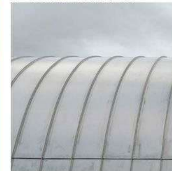
01 - Couverture inox du bâtiment
