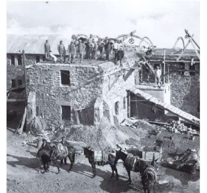
Chantier de l'hôtellerie des Laquets
