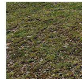
04 - Toiture terrasse revégétalisées avec espèces endémiques sélectionnées
