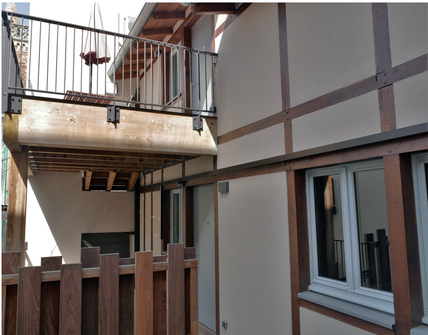
Vue sur colombage depuis la coursive - Photo : Envirobot Occitanie
