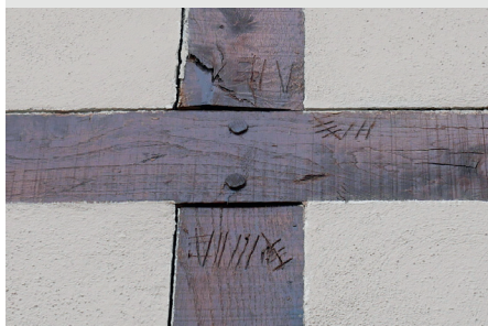
Marquages d'assemblage du colombage Photo : Envirobot Occitanie
