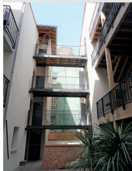
Vue sur le nord depuis la cour intérieure Photo : Envirobot Occitanie
