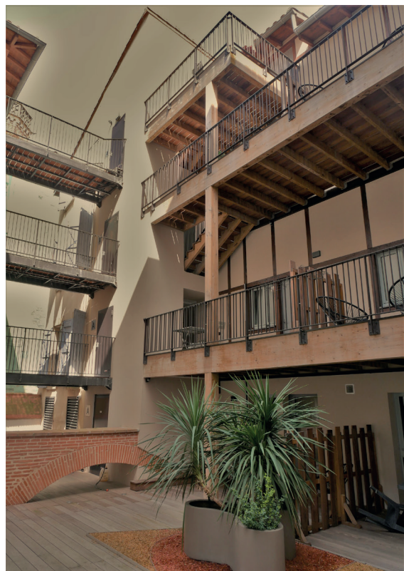
À gauche : vue sur des passerelles métalliques depuis l'entrée de la résidence
