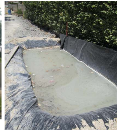
Bassin de décantation des eaux de lavages des bennes à béton
