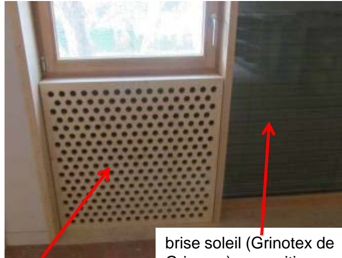
l'ouvrant de ventilation naturelle en allège avec dispositif de protection
