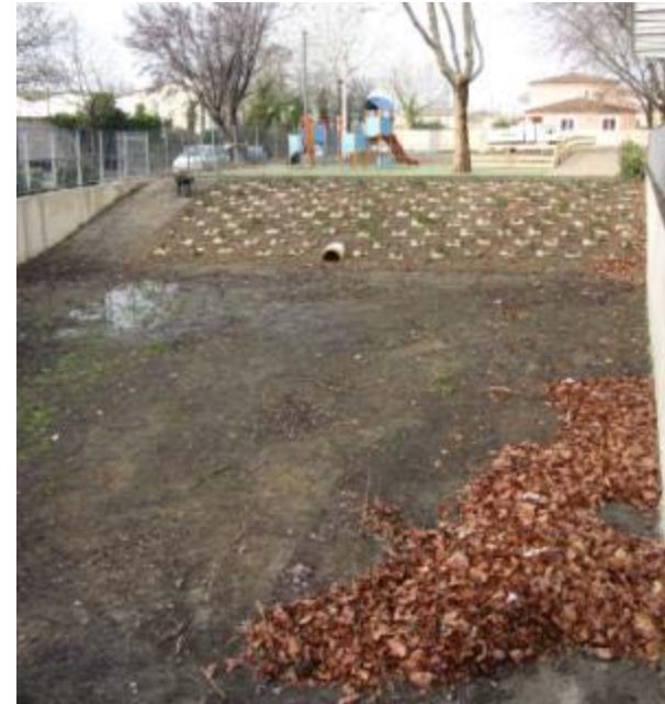
Bassin de rétention
