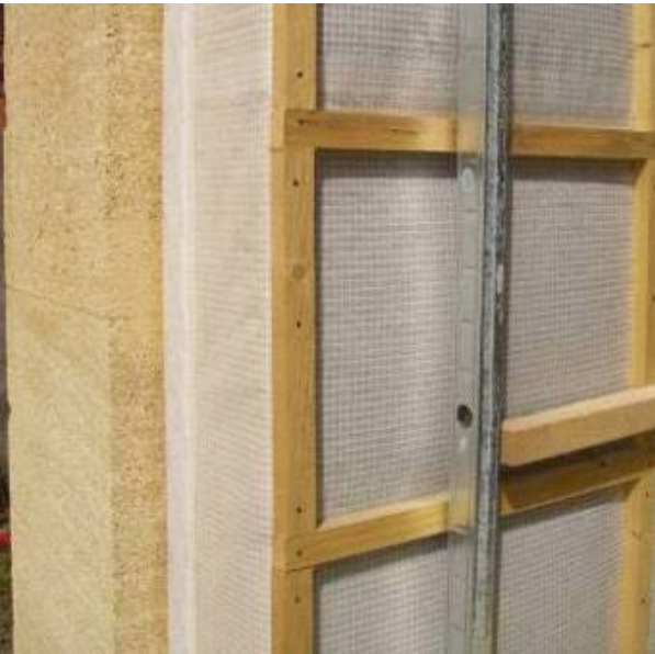
Isolation intérieure des murs en pierre de Vers
