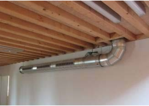
Gaine de soufflage dans une salle de classe
