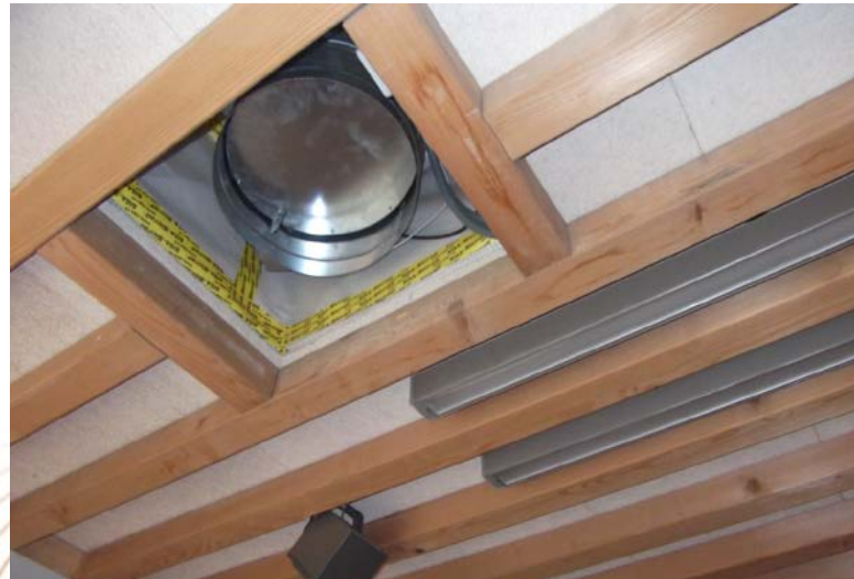
Le registre d'ouverture de la tourelle d'extraction d'air
