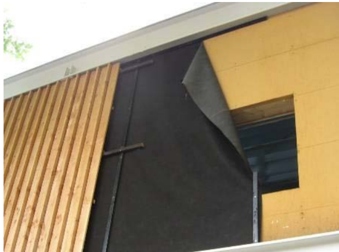
façade en cours de finition : Bardage bois ajouré, pare-pluie anti UV et isolant fibre de bois
