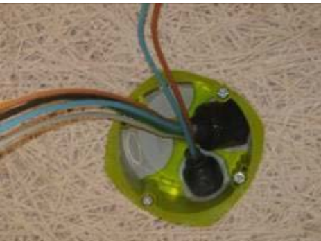
Traitement de l'étanchéité à l'air des gaines électriques
