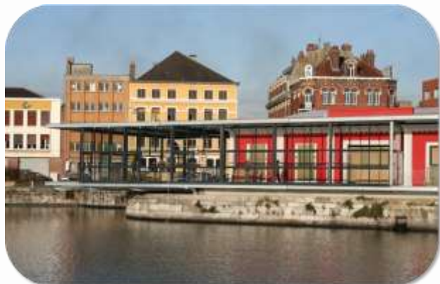
Restaurant autour de l'ancienne station météorologique, Dunkerque (AGUR)
