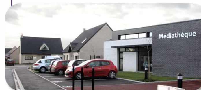
Médiathèque intégrée à un lotissement, Uxem (AGUR)
