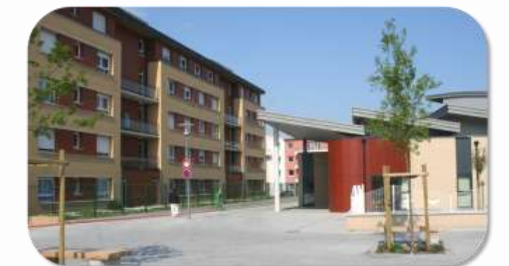
Logements et école dans le quartier Neptune, Dunkerque (AGUR)
