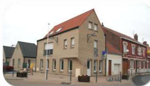
Opération de logements sociaux avec coiffeur en rez-de-chaussée, centre de Brouckerque (AGUR)
