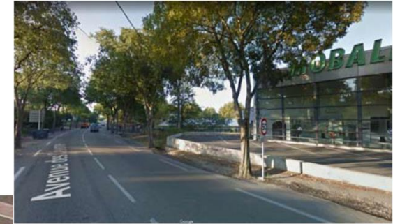
3 – Sur le D999, bâtiment commercial
