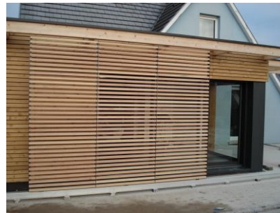
Brise-soleil vertical à l'Ouest
